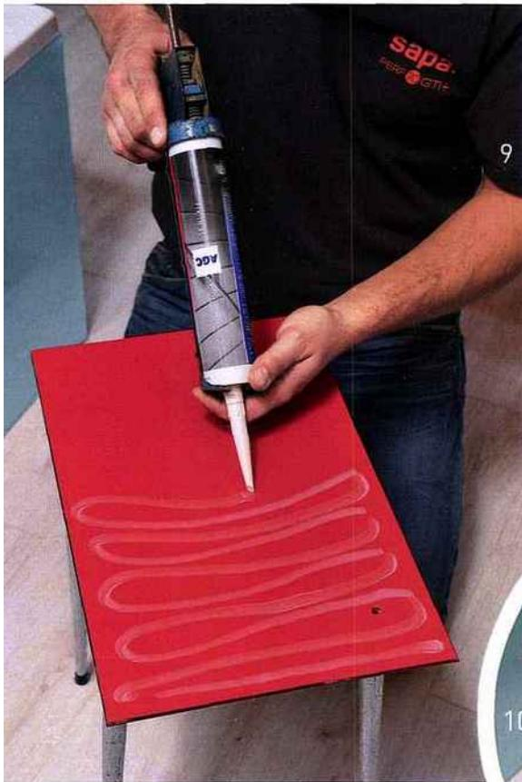
**9** En forme de serpent, l'encollage du panneau est réalisé avec le produit « Fix-In SL » (AGC). Ce silicone transparent garantit une bonne adhérence entre le verre et le support. Celui-ci n'étant pas poreux, un primaire est inutile.
