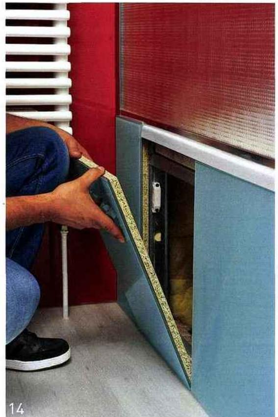
**14** Une trappe d'accès au siphon de la baignoire est créée. Le tablier de la baignoire est décoré avec le verre « Lacobel » coloris « blue pastel ». Il repose sur un panneau aggloméré de qualité CTBH, adapté pour les milieux partiellement humides.
